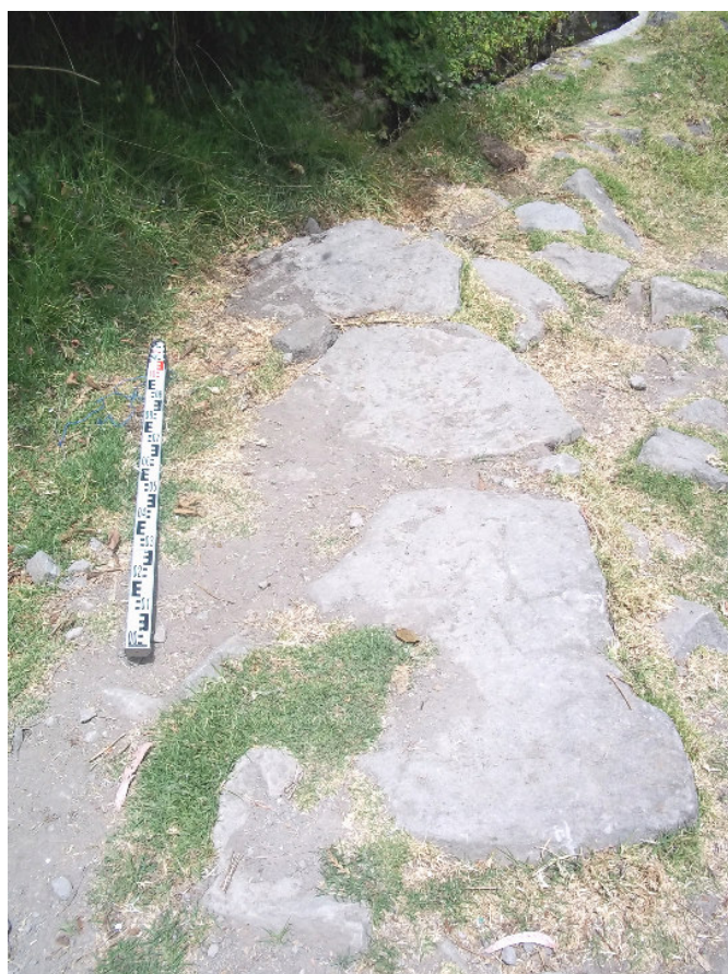
Figura 6. Estado del Qhapaq Ñan , tramo Sevilla-Nizag (0 + 200 km).
