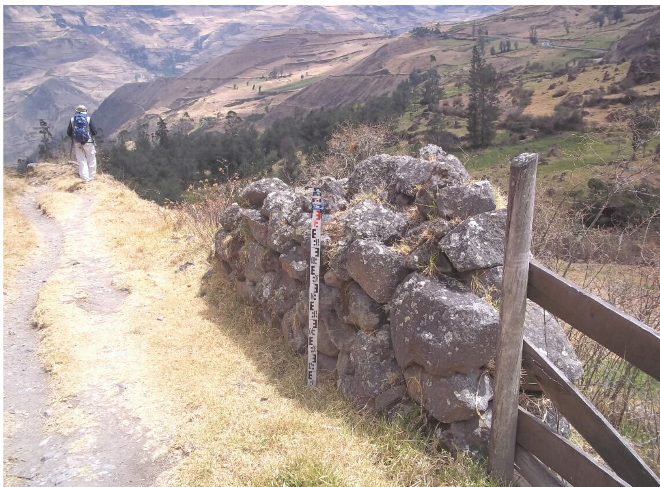
Figura 4. Inicio del tramo del Qhapaq Ñan en Sevilla (0 + 025 km).
