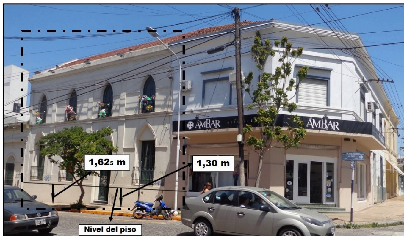
Figura 3. Foto de la actual casa de Juan Fugl, donde se puede observar en el recuadro punteado la estructura original de la casa, con la línea negra marcando el piso de madera de pino tea y cómo este se distancia de la vereda que respeta la pendiente natural del terreno. Esta pendiente desagua en el arroyo del Fuerte (actualmente entubado).
