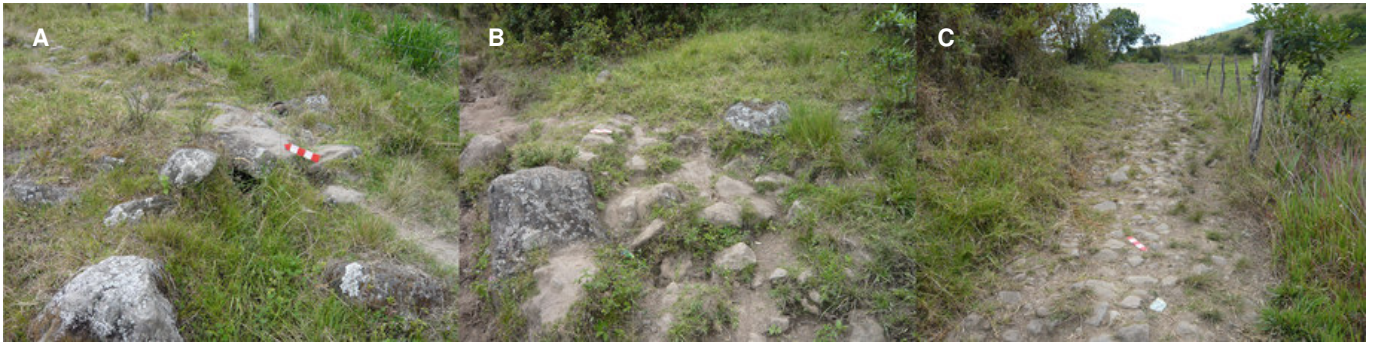
Figura 6. A) Atarjeas que atraviesan el camino antiguo. B) Detalle del empedrado. C) Segmento de camino.
