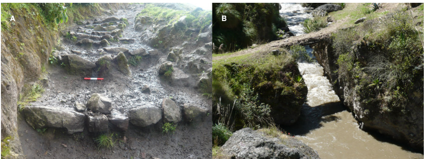
Figura 9. A) Calzada con escalones de roca. B) Puente en el sector Potrero Chaca.
