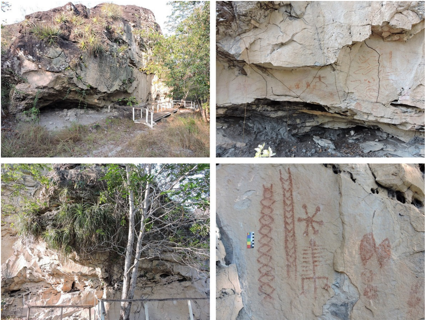
Figura 5. Detalhes de problemas de degradação que atingem a Pedra da Inscrição: deslocamentos do arenito-suporte, plantas presas ao suporte rochoso, ninhos e galerias de cupins, manchas geradas por umidade e proliferação de microrganismos, passarela instalada de forma inadequada e construída com materiais não recomendados, pichações.
