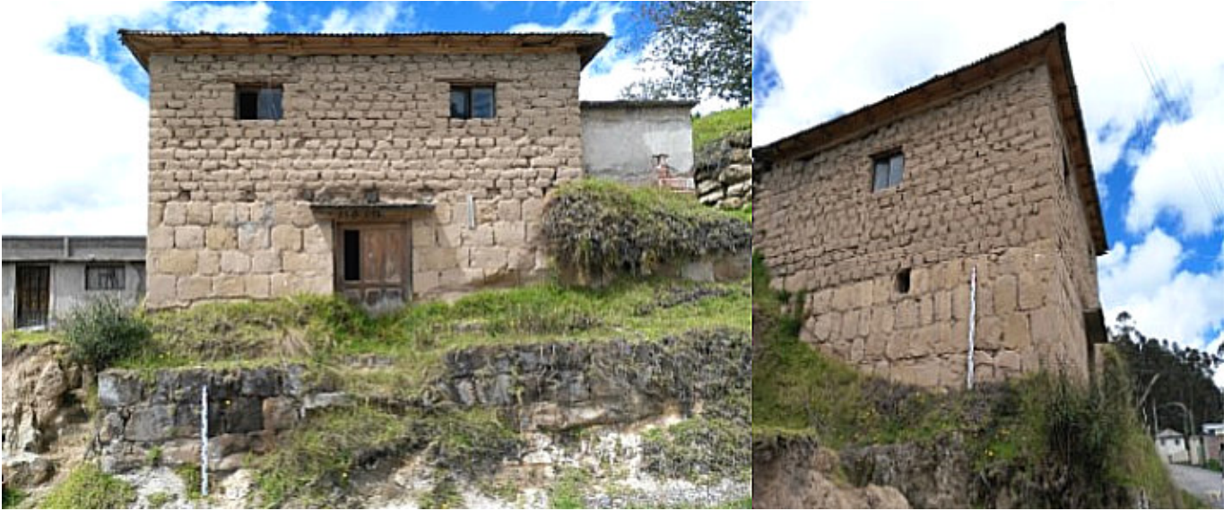
Figura 4. Casa de bloques de andesita, cangahua y adobe de Obraje de Cacha.
