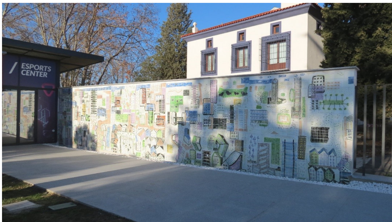
Figura 8. Estado del mural después de la restauración y de la rehabilitación del pabellón con su entorno. Fuente: Laura de la Colina y Marta Plaza.
